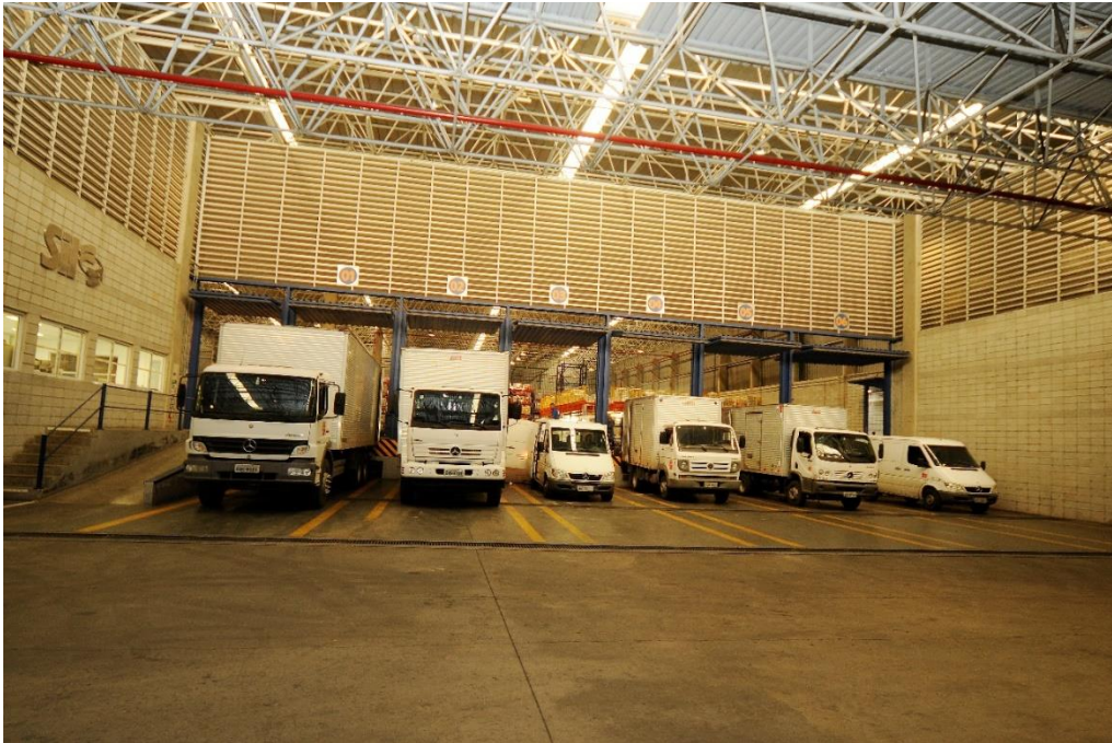
Setor de expedição das docas no galpão da Sil na região metropolitana de Guarulhos (SP) | Foto: Sil Fios e Cabos Elétricos
